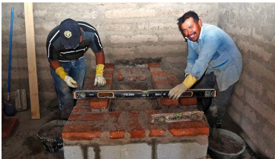
Ofensetzer bei der Montage eines Holzsparofens
